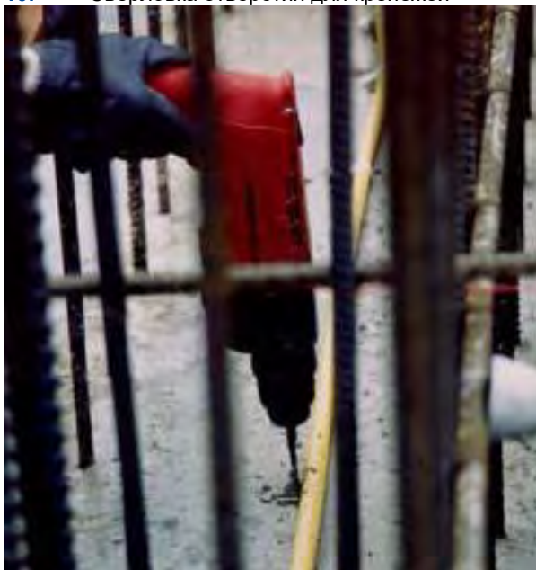
10. Сверловка отверстия для крепежей
