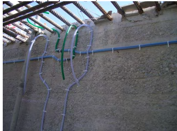
13. Установка системы на прямом отрезке
