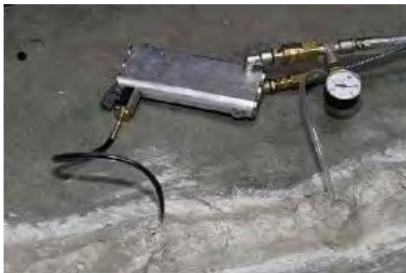
Рисунок 3. Нагнетание средства MasterInject 1380 при помощи двухкомпонентного насоса для ремонта бетонного пола.
