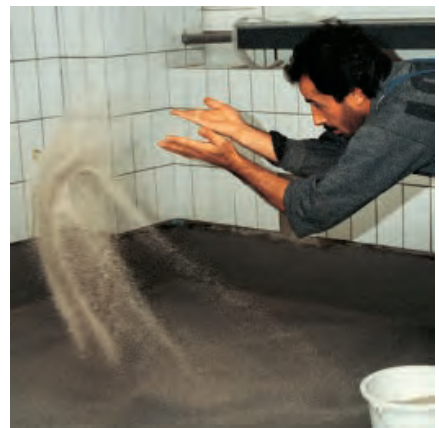
... а затем присыпать новое покрытие кварцевым песком (размер частиц 0,3–0,8 мм).
