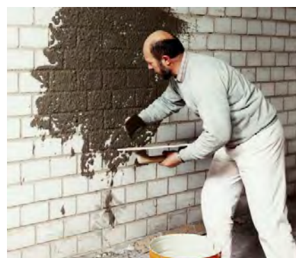
С PCI Latex нанесенная набрызгом штукатурка имеет улучшенное сцепление с основанием
