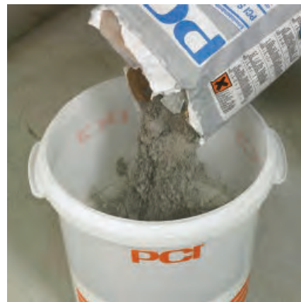
Добавить порошок PCI Seccoral 2K Rapid.
