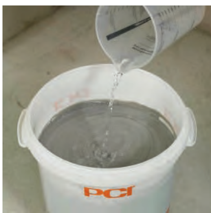
Добавить воды для нанесения валиком (1 б).
