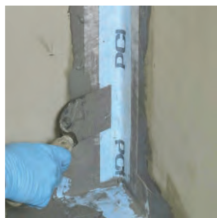
Наклеить гидроизоляционную ленту PCI Pесitare в углах.
