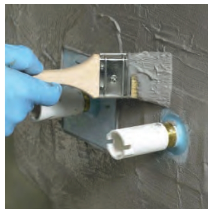
С помощью подходящего шпателя нанести второй и, возможно, третий слой до получения необходимой общей толщины покрытия.
