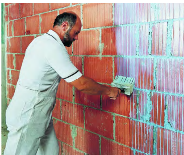
PCI Gisogrund повышает сцепление гипсокартона и известково-гипсовой штукатурки с кирпичной кладкой.
