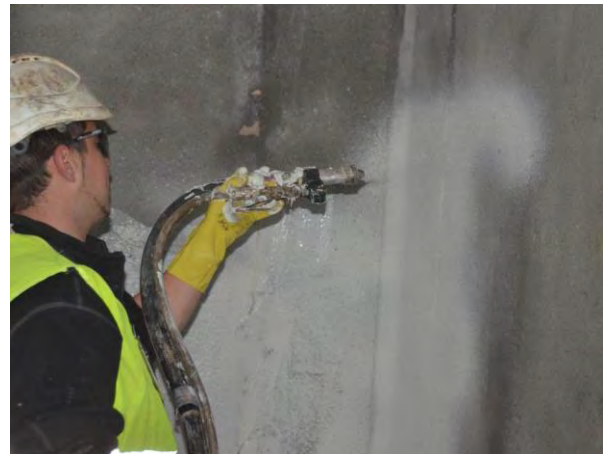
Нанесение состава MasterSeal P 385 пневматическим распылителем
