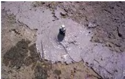
Рисунок 2. Герметизация пакера, установленного на поверхности и трещины при использовании соответствующего средства MasterBrace/MasterFlow
