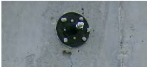
Рисунок 1. Размещение устанавливаемого на поверхности nipples по центру отверстия трещины.
